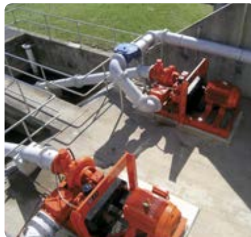
Стационарные насосы с электроприводом Dri-Prime, подающие стоки после фильтрации на стадию хлорирования перед сбросом.
